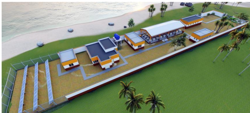
Figure 11 Travaux de construction des bâtiments du kiosque de pré-électrification et du « complexe-pêche » dans les districts de Mananara Nord - ANIRIBE
