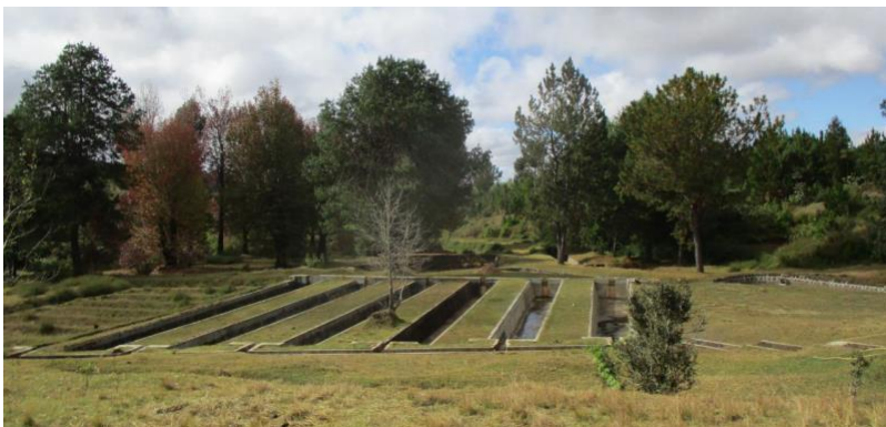
Figure 5 Réhabilitation des bassins et de la piste de la pisciculture Manjakatampo
