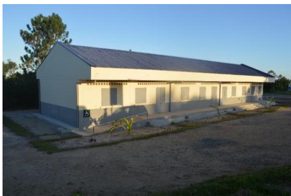
Figure 3 Travaux d'assistance technique pour le suivi de chantier dans le cadre du projet de construction d'écoles primaires (phase IV) en République de Madagascar
