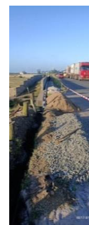
Figure 4 Contrôle interne des travaux du déploiement fibre optique GULSFAT sur la RN2
