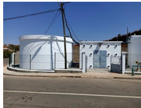
Figure 6 Travaux de construction d'un réservoir d'eau de 150m 3 sis à Soavina
