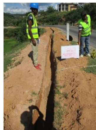
Figure 4 Contrôle interne des travaux du déploiement fibre optique GULSFAT sur la RN2
