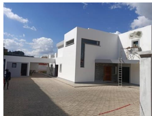
Figure 8 Travaux de construction d'une villa dans la zone Forello Tanjombato
